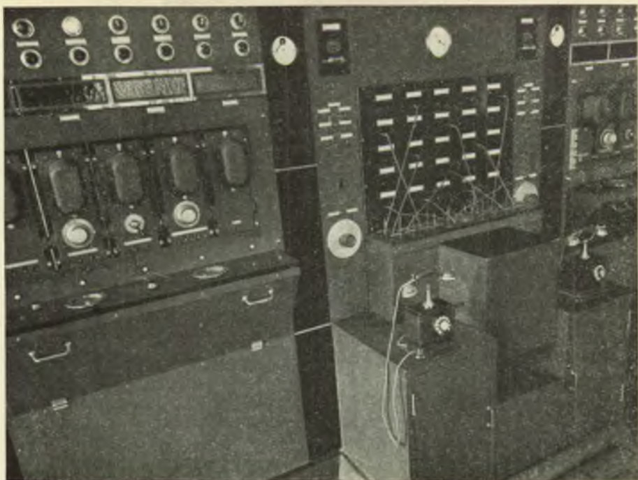
Technische dienst. De modulatie-paneelen, Bolwerkstraat, te Brussel.
