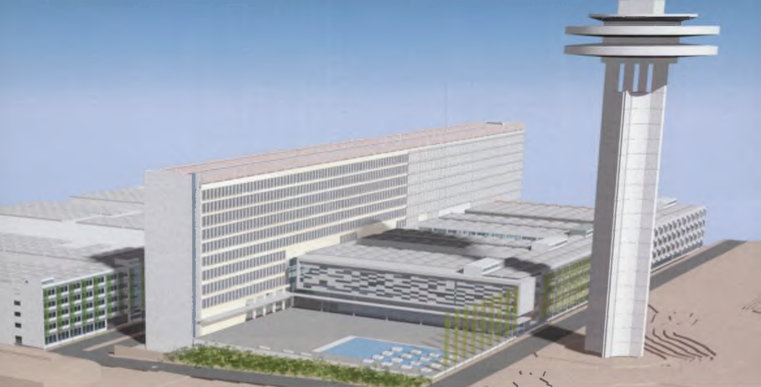
Het omroepgebouw wordt met de realisatie van het TOM-project aangepast aan de noden van een modern mediabedrijf.
